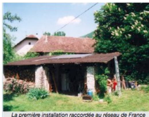
La première installation raccordée au réseau de France
