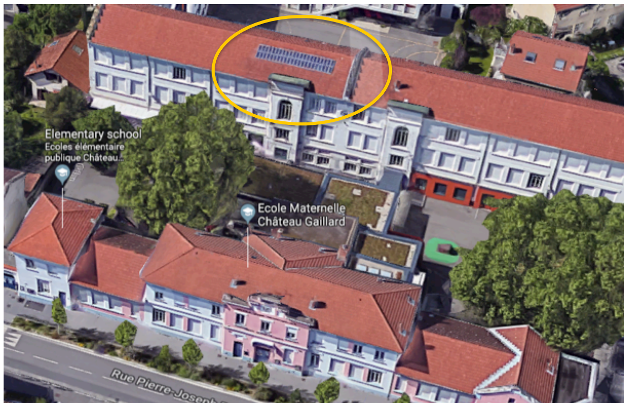
L'école Château Gaillard à Villeurbanne / Source : Google Maps
