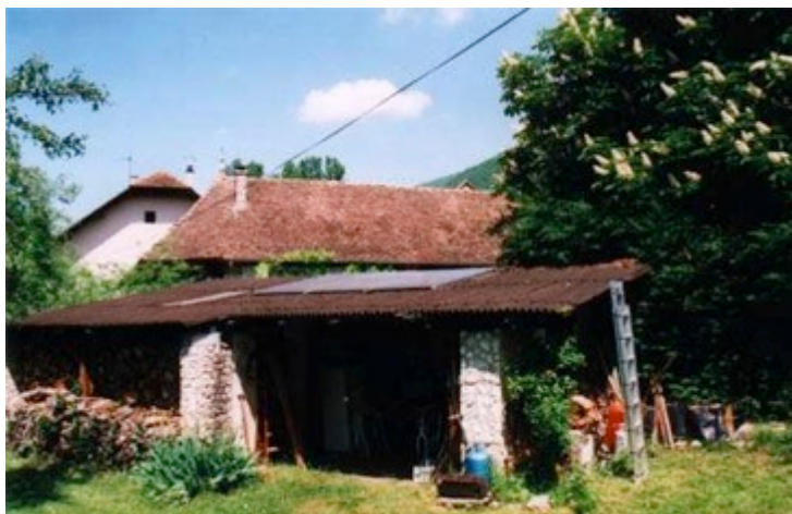
Phébus n°1 est le nom du premier toit solaire raccordé au réseau en France
